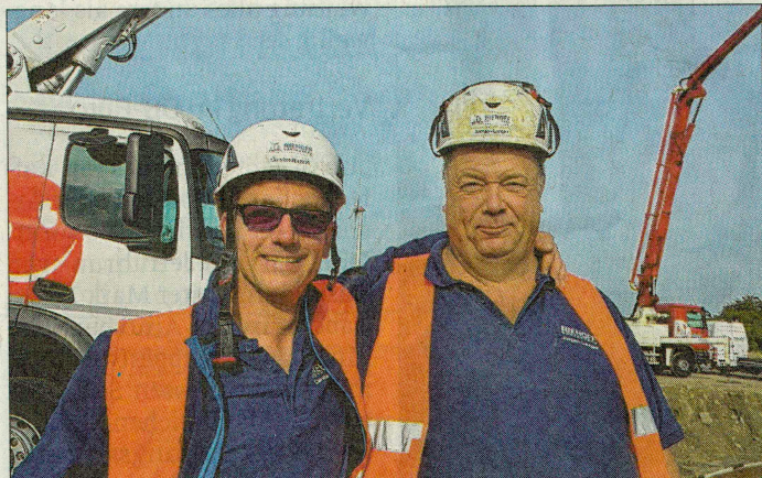
Firmenchef Carsten Niehoff (links) und Polier Jürgen Langer sind mit dem Fundamentaufbau recht zufrieden.
