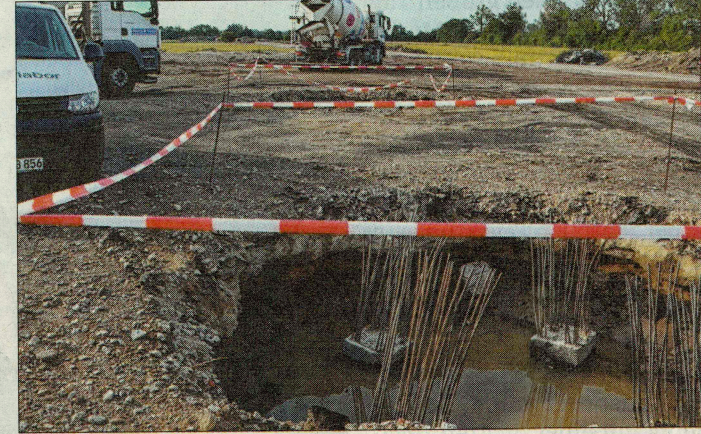
Vor dem weiteren Aufbau der Windkraftanlage müssen noch die Stützfundamente für den Kran gesetzt werden.
