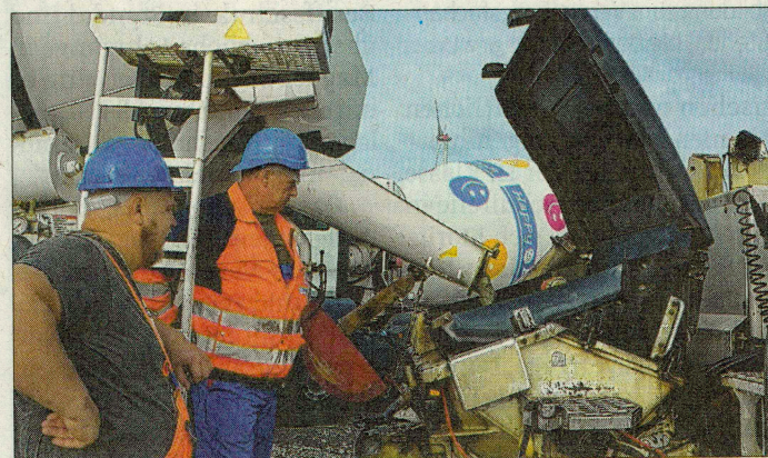
Unentwegt werden die Pumpenanlagen mit Spritzbeton versorgt. Aus vier Werken werden 95 Lkw-Ladungen herangefahren.
