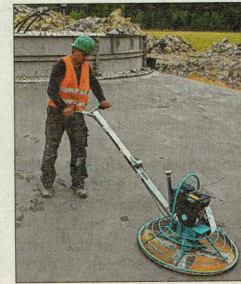
Zum Abschluss wird der Fundamentsockel geschliffen.
